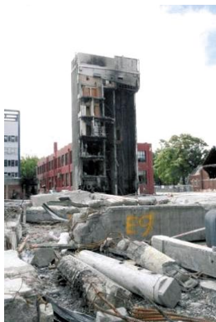
Slika 15 • Popolna porušitev stavbe televizije Canterbury. Med poglavitnimi vzroki za porušitev je bil slab stik etažnih plošč z jedrom. (Vir: Ken Elwood)
