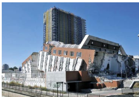
Slika 13b • Stavba se je med potresom prelomila v pritličju in prevrnila
