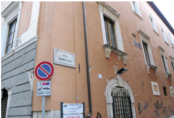
Slika 1a • Železne in jeklene vezi so zagotovile soliden odziv zidane stavbe v starem jedru L'Aquile
