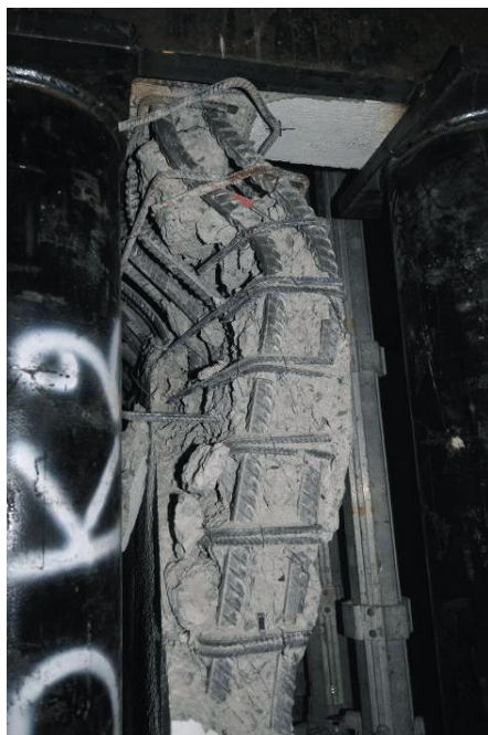
Slika 10d • Uklon pravokotno na ravnine relativno tanke stene
