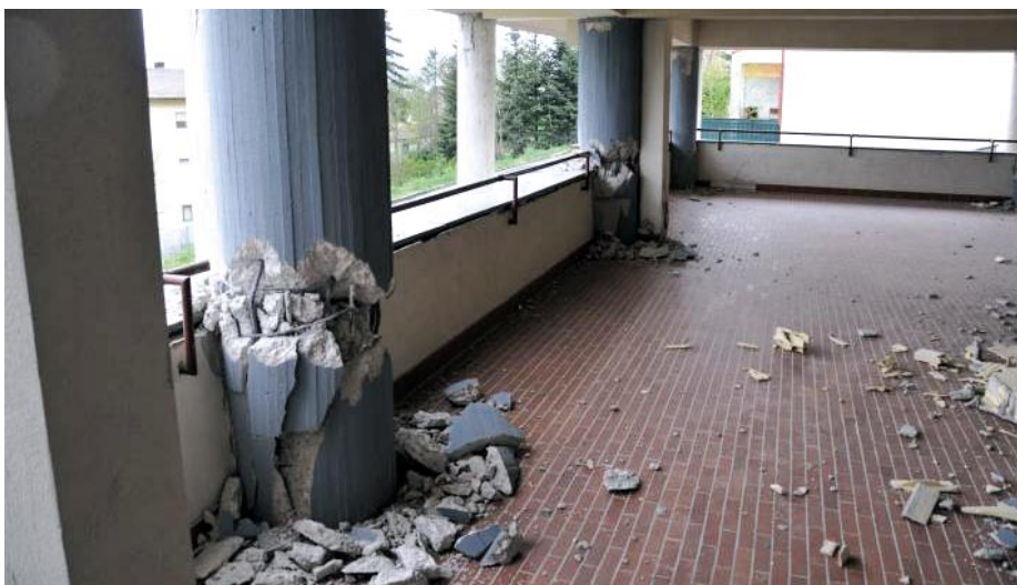
Slika 5 • Strižna porušitev stebra ob togem parapetu/ogradi
