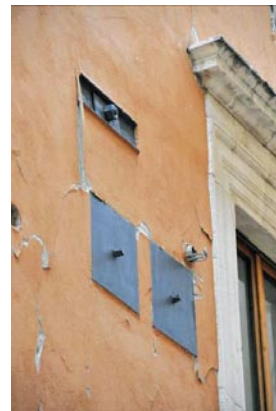
Slika 1b • Detajl pred kratkim vgrajenih jeklenih vezi (dodatno k že obstoječim – železnim)
