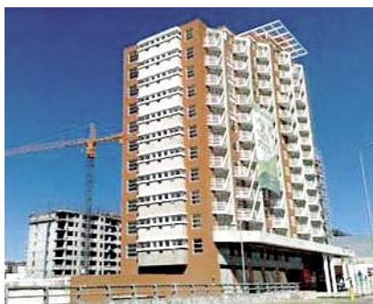
Slika 13a • Stavba Alto Rio v času graditve leta 2008
