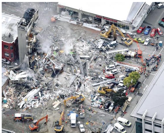
Slika 15 • Popolna porušitev stavbe televizije Canterbury. Med poglavitnimi vzroki za porušitev je bil slab stik etažnih plošč z jedrom. (Vir: Ken Elwood)
