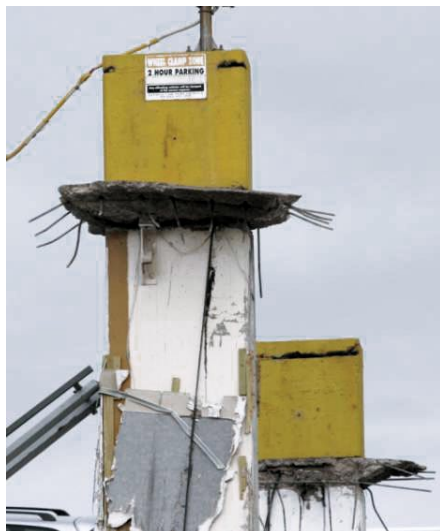
Slika 17 • Porušitev zaradi preboja prednapetih etažnih plošč v garažni hiši (Vir: Ken Elwood)
