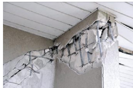
Slika 6b • Neduktilni konstrukcijski detajli armature v steni
